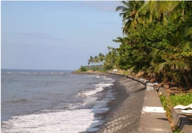
Gambar 4. Tanggul beton di Nusa Penida
