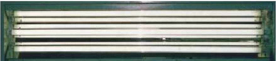
**Gambar 5.3. Satu Lampu Tripospor Dengan Reflektor
