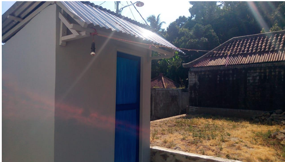
Gambar 7. Bangunan WC Umum
