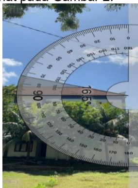
Gambar 2. Tampilan Pengukuran Sudut Kemiringan Atap
