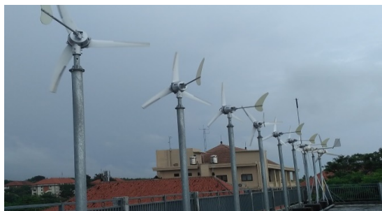
Gambar 8 : PLTB Gedung DH Teknik Elektro Udayana
