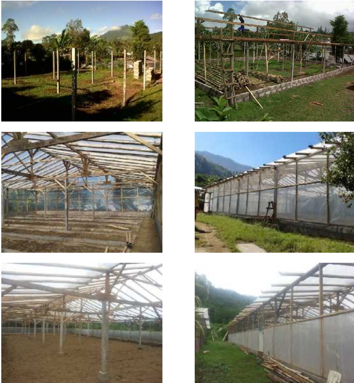
Gambar 1. Pembangunan greenhouse untuk budidaya bunga krisan
