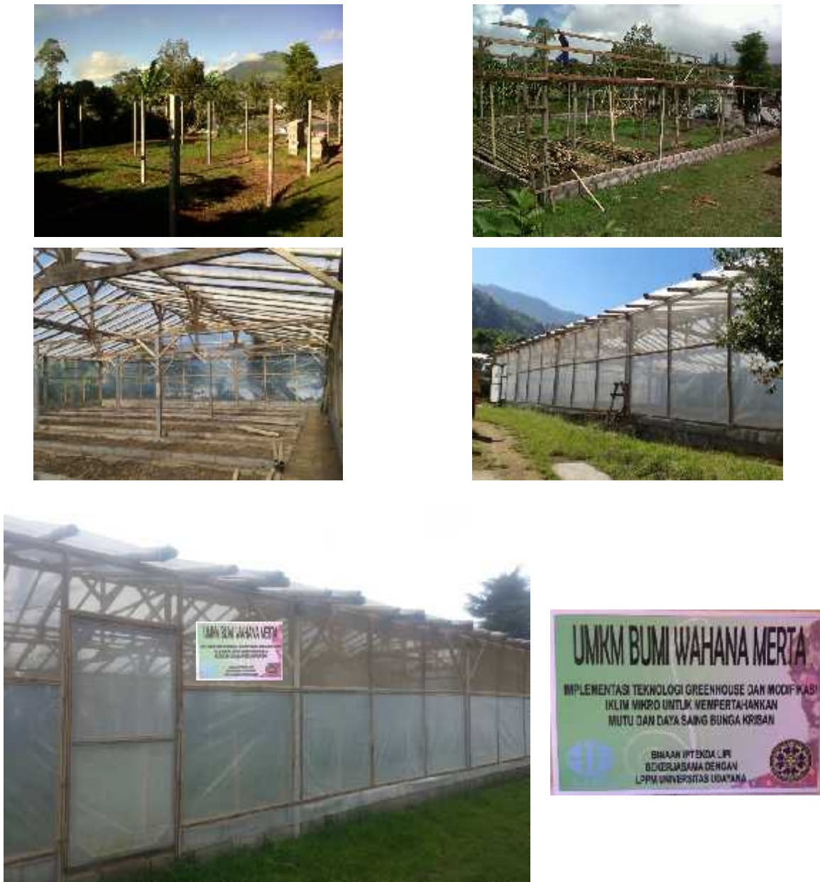
Gambar 4. Konstruksi greenhouse budidaya bunga krisan
